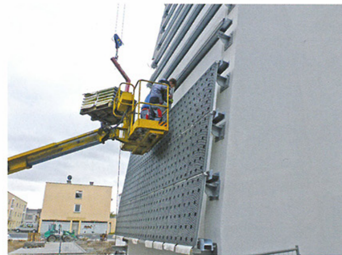
Die Fassadenbegrünungselemente werden in die Schienen eingehängt; die Bepflanzung folgt danach.
