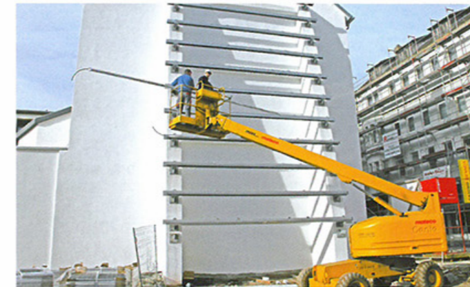
Die Einhangschienen werden mittels Klemmen auf die Doppel-H-Träger gesetzt.
