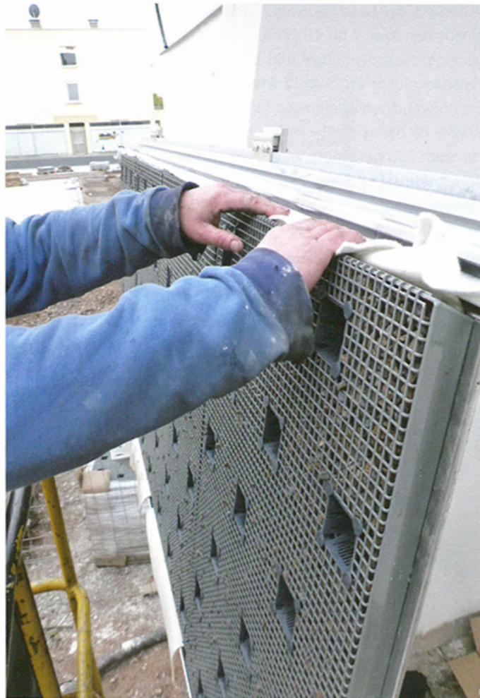
Die Fassadenbegrünungselemente werden in die Schienen eingehängt; die Bepflanzung folgt danach.
