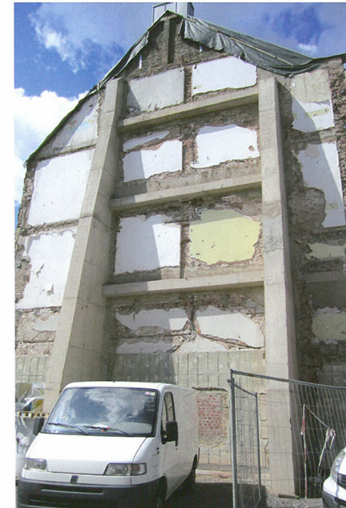
Die noch zu begrünende Wand nach den Abbrucharbeiten
